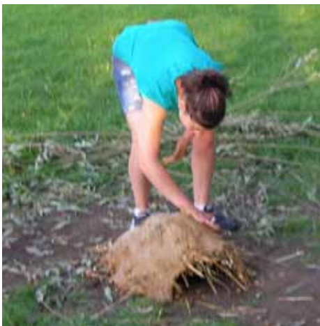
... und Leni den Ofen verputzt ...
